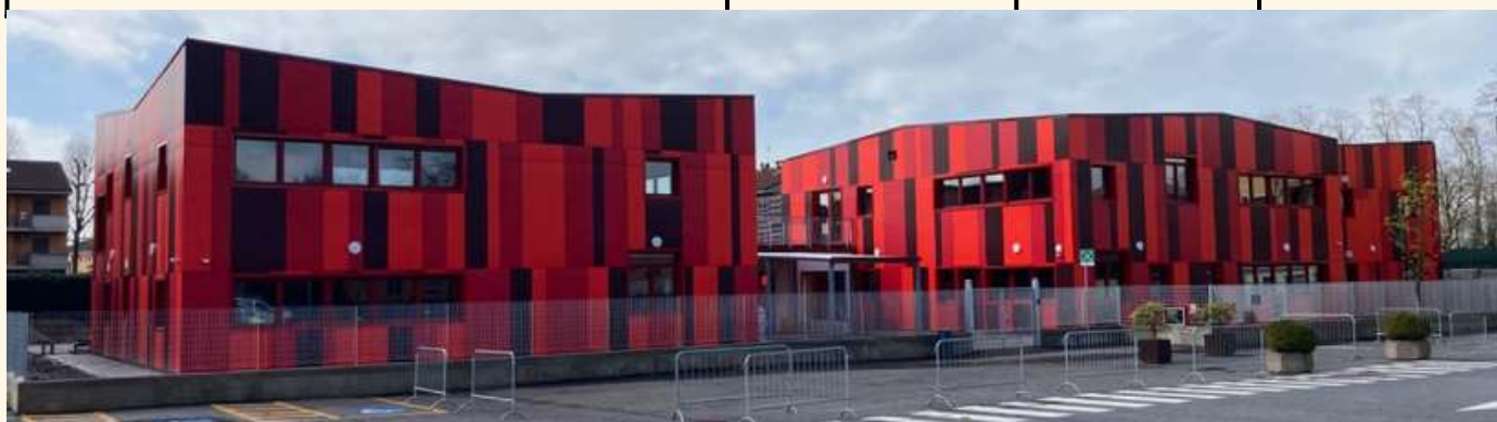
Nuova scuola elementare
